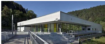
2013 Neubau Vierfeld-Sporthalle Calw
