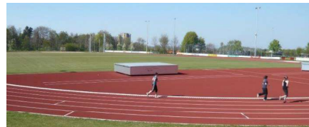
2010 Neubau Ernweisenstadion Mössingen
