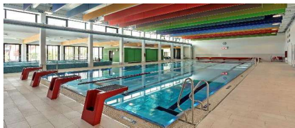
2017 Sanierung und Erweiterung Hallenbad Dornstadt
