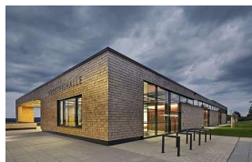
2013 Neubau Dreifeld-Sporthalle Dornstetten
