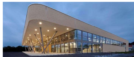
2019 Neubau Sport- und Mehrzweckhalle mit Mensa Bibrishalle Herbrechtingen
