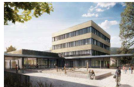
2020 Sanierung und Erweiterung Schillerschule Dettingen
