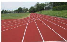
2017 Sanierung Sportanlagen Engstingen-Haid
